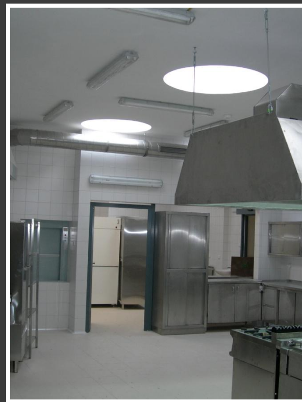
Instalacje wentylacji Kuchni
