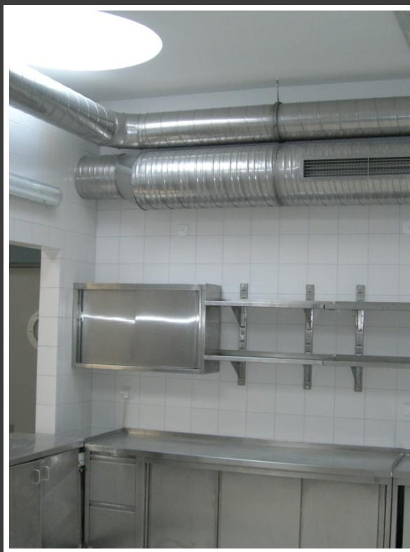
Instalacje wentylacji Kuchni
