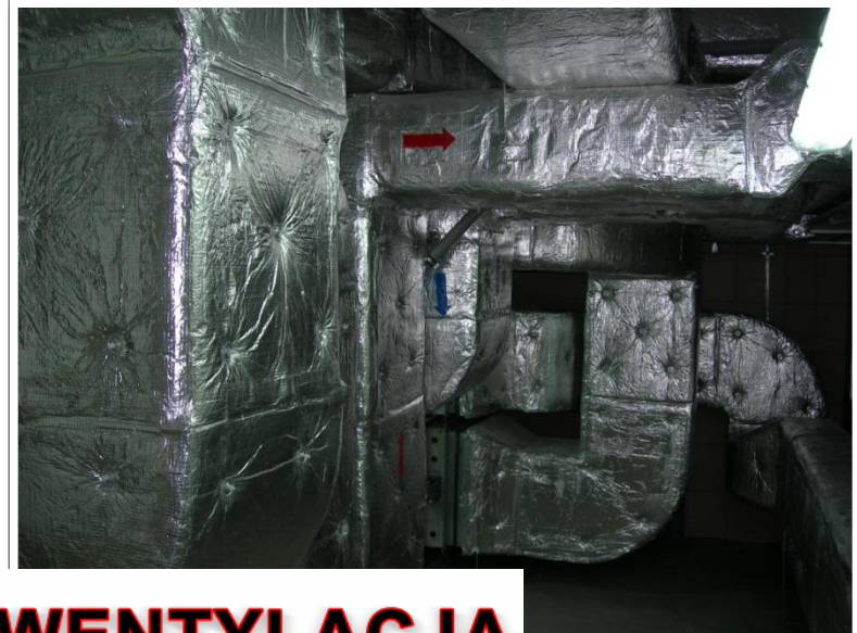
Izolacja kanałów wentylacyjnych
