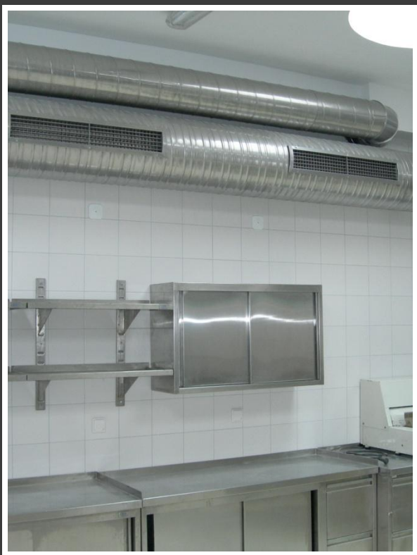
Instalacje wentylacji Kuchni
